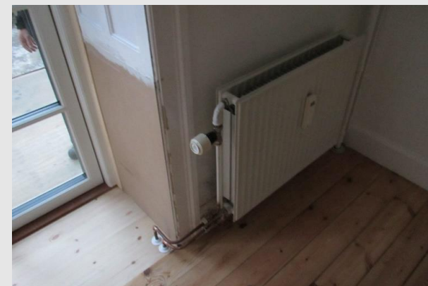
Eksempel - færdig lysning (uden profilering) og flyttet radiator
